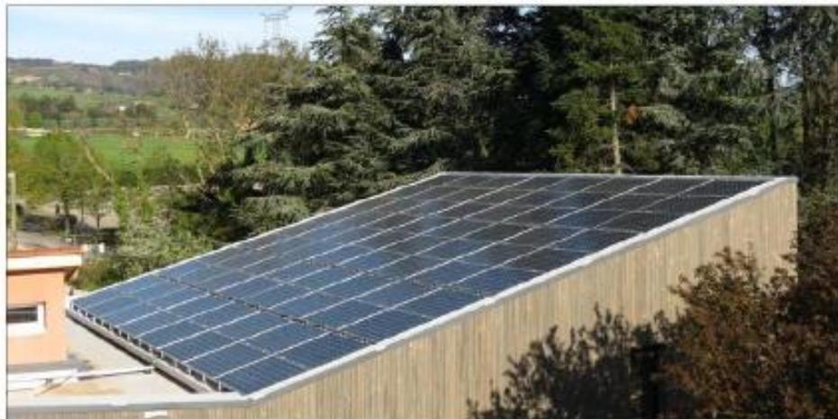
Les panneaux photovoltaïques installés sur le toit du siège de la Communauté de communes des Vallons du Lyonnais à Vaugneray. Ce bâtiment est à la fois basse consommation et labélisé Bepos pour Bâtiment à énergie POSitive. Photo SOL/DR
